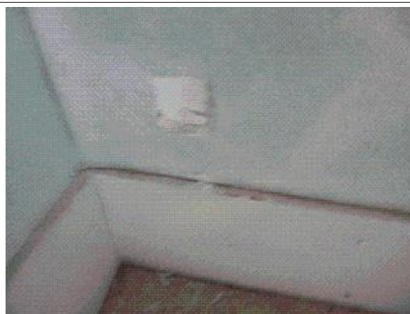
Prélèvement - P23 : CH CHOLET INTERNAT / RDC / 13.8.01.18 - Enduit- (Absence d'amiante)
