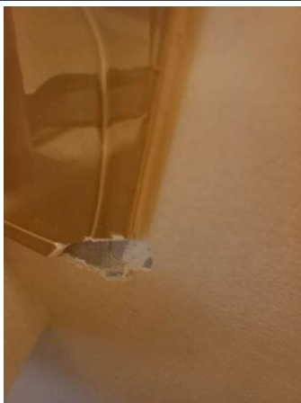
Prélèvement - P111 : CH CHOLET INTERNAT / R+3 / 13.3.01.10 - Colle de faïence- (Absence d'amiante)
