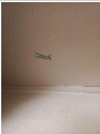
Prélèvement - P26 : CH CHOLET INTERNAT / RDC / 13.8.01.01 - Enduit - BE- (Présence d'amiante)
