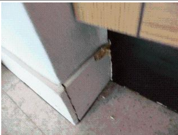
Prélèvement - P11 : CH CHOLET INTERNAT / RDC / 13.8.01.18 - Peinture- (Absence d'amiante)
