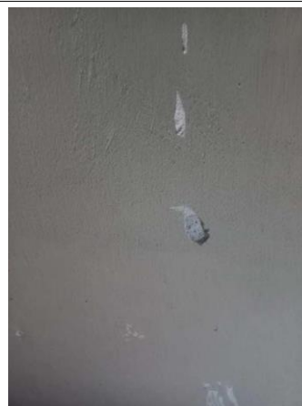
Prélèvement - P116 : CH CHOLET INTERNAT / R-1 / Station - Enduit- (Absence d'amiante)
