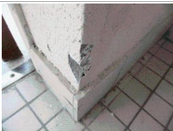
Prélèvement - P40 : CH CHOLET INTERNAT / RDC / 13.8.01.21 - Enduit - BE- (Présence d'amiante)
