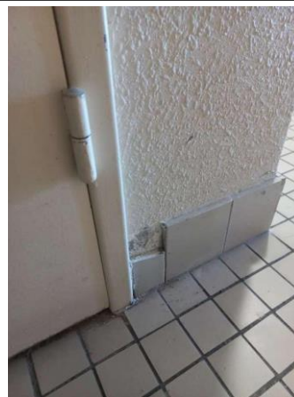
Prélèvement - P94 : CH CHOLET INTERNAT / R+3 / 13.3.01.11 - Colle de plinthe- (Absence d'amiante)
