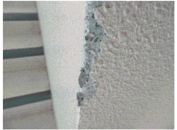
Prélèvement - P69 : CH CHOLET INTERNAT / R+2 / 13.8.01.06 - Enduit - BE- (Présence d'amiante)
