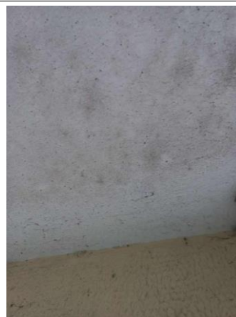
Prélèvement - P122 : CH CHOLET INTERNAT / RDC / Façade - Enduit- (Absence d'amiante)
