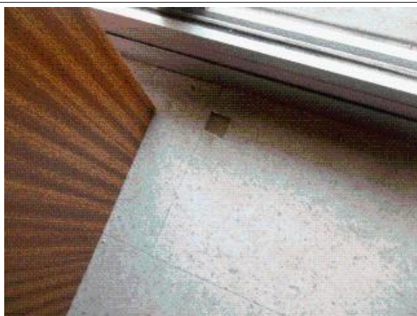
Prélèvement - P77 : CH CHOLET INTERNAT / R+2 / 13.2.01.16 - Dalle de sol- (Absence d'amiante)
