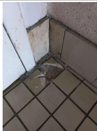
Prélèvement - P100 : CH CHOLET INTERNAT / R+3 / 13.3.01.10 - Colle de carrelage- (Absence d'amiante)
