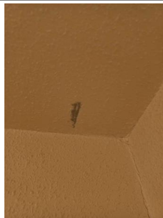
Prélèvement - P75 : CH CHOLET INTERNAT / R+2 / 13.2.01.06 - Enduit - BE- (Présence d'amiante)
