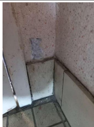
Prélèvement - P104 : CH CHOLET INTERNAT / R+3 / 13.3.01.10 - Enduit- (Absence d'amiante)
