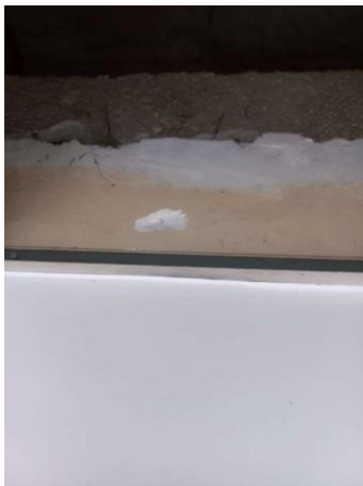
Prélèvement - P7 : CH CHOLET INTERNAT / RDC / 13.8.01.28 - Enduit- (Absence d'amiante)
