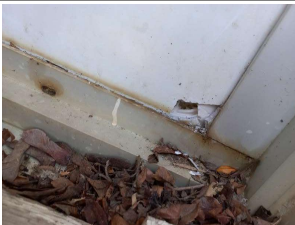
Prélèvement - P9 : CH CHOLET INTERNAT / RDC / 13.8.01.28 - Plaque - EP- (Présence d'amiante)
