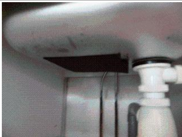
Prélèvement - P38 : CH CHOLET INTERNAT / RDC / 13.8.01.18 - Plaque bitumineuse- (Absence d'amiante)
