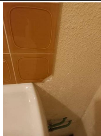
Prélèvement - P31 : CH CHOLET INTERNAT / RDC / 13.8.01.02 - Colle de faïence - BE- (Présence d'amiante)
