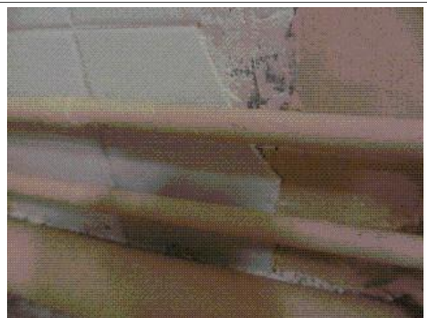
Prélèvement - P84 : CH CHOLET INTERNAT / R+2 / 13.2.01.16 - Colle de faïence- (Absence d'amiante)
