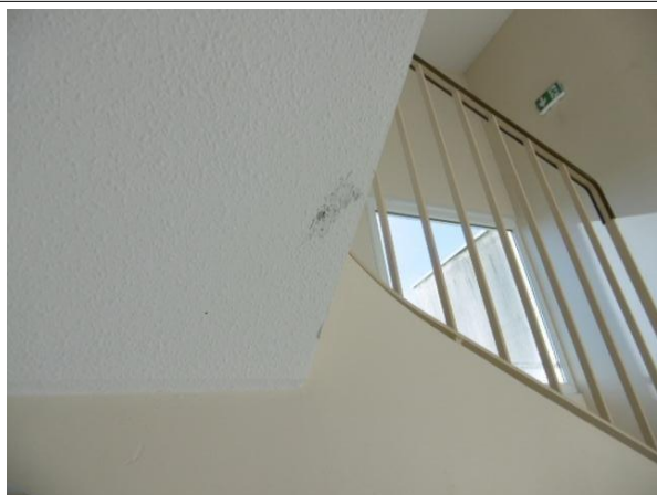
Prélèvement - P70 : CH CHOLET INTERNAT / R+2 / 13.8.01.06 - Enduit - BE- (Présence d'amiante)
