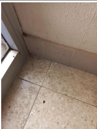
Prélèvement - P24 : CH CHOLET INTERNAT / RDC / 13.8.01.01 - Colle de carrelage- (Absence d'amiante)
