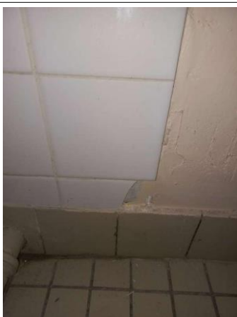
Prélèvement - P113 : CH CHOLET INTERNAT / R+3 / 13.3.01.10 - Colle de faïence- (Absence d'amiante)
