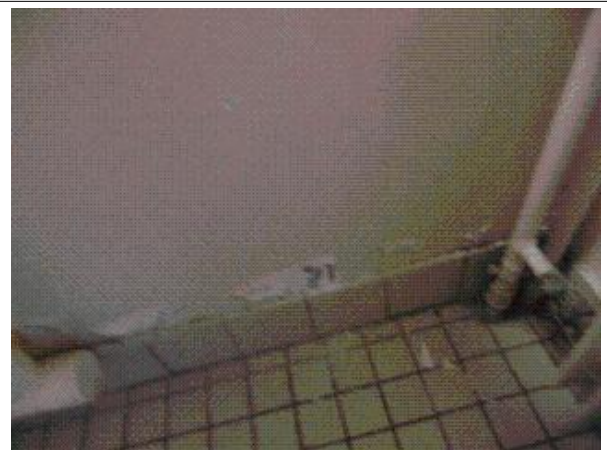
Prélèvement - P59 : CH CHOLET INTERNAT / R+1 / 13.1.01.13 - Enduit- (Absence d'amiante)
