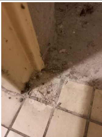
Prélèvement - P93 : CH CHOLET INTERNAT / R+3 / 13.3.01.11 - Colle de carrelage- (Absence d'amiante)
