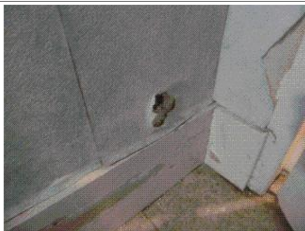
Prélèvement - P87 : CH CHOLET INTERNAT / R+2 / 13.2.01.16 - Enduit- (Absence d'amiante)
