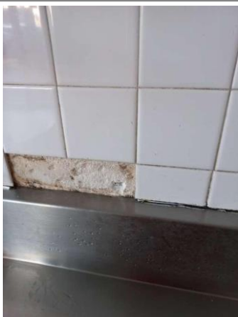
Prélèvement - P5 : CH CHOLET INTERNAT / RDC / 13.8.01.28 - Colle de faïence- (Absence d'amiante)
