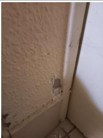
Prélèvement - P74 : CH CHOLET INTERNAT / R+2 / 13.2.01.06 - Enduit - BE- (Absence d'amiante)
