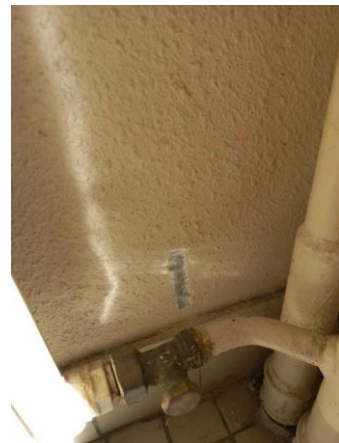
Prélèvement - P73 : CH CHOLET INTERNAT / R+2 / 13.2.01.06 - Enduit - BE- (Présence d'amiante)
