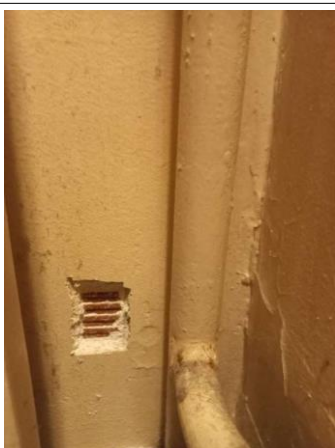
Prélèvement - P107 : CH CHOLET INTERNAT / R+3 / 13.3.01.10 - Enduit- (Absence d'amiante)
