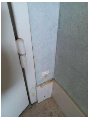
Prélèvement - P105 : CH CHOLET INTERNAT / R+3 / 13.3.01.10 - Enduit- (Absence d'amiante)
