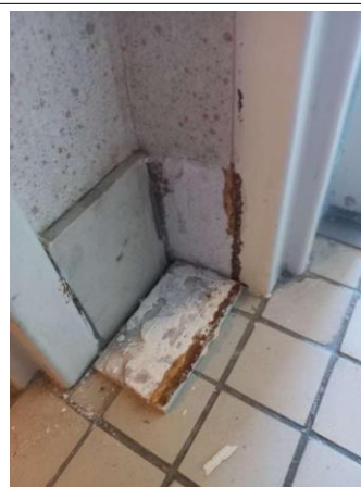
Prélèvement - P102 : CH CHOLET INTERNAT / R+3 / 13.3.01.10 - Colle de plinthe- (Absence d'amiante)
