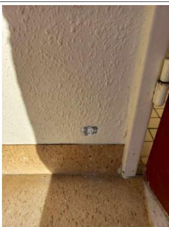
Prélèvement - P34 : CH CHOLET INTERNAT / RDC / 13.8.01.22 - Enduit - BE- (Présence d'amiante)
