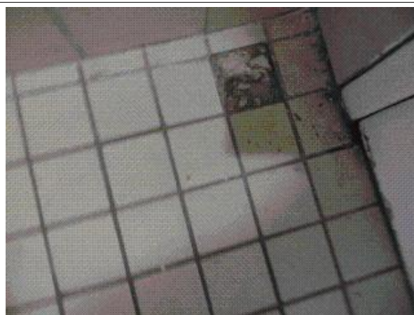
Prélèvement - P78 : CH CHOLET INTERNAT / R+2 / 13.2.01.16 - Colle de carrelage- (Absence d'amiante)
