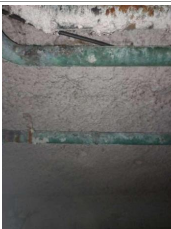
Prélèvement - P119 : CH CHOLET INTERNAT / R-1 / Vide Sanitaire - Flocage- (Absence d'amiante)
