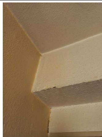
Prélèvement - P25 : CH CHOLET INTERNAT / RDC / 13.8.01.01 - Enduit- (Absence d'amiante)
