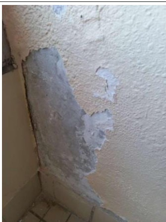
Prélèvement - P95 : CH CHOLET INTERNAT / R+3 / 13.3.01.11 - Enduit - BE- (Présence d'amiante)
