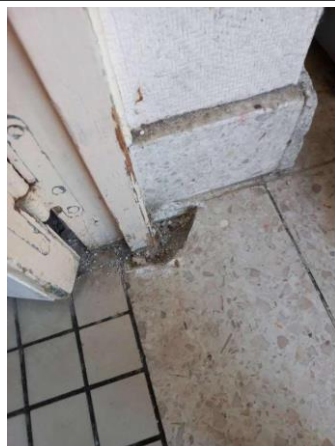
Prélèvement - P14 : CH CHOLET INTERNAT / RDC / 13.8.01.26 - Colle de plinthe- (Absence d'amiante)
