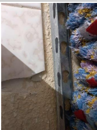
Prélèvement - P28 : CH CHOLET INTERNAT / RDC / 13.8.01.02 - Colle de faïence- (Absence d'amiante)
