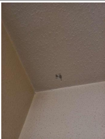
Prélèvement - P97 : CH CHOLET INTERNAT / R+3 / 13.3.01.11 - Enduit - BE- (Présence d'amiante)
