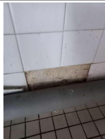
Prélèvement - P6 : CH CHOLET INTERNAT / RDC / 13.8.01.28 - Colle de faïence- (Absence d'amiante)
