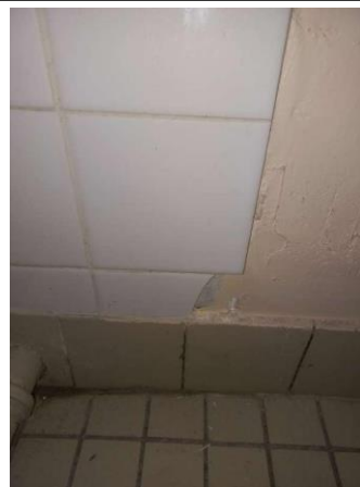
Prélèvement - P112 : CH CHOLET INTERNAT / R+3 / 13.3.01.10 - Colle de faïence- (Absence d'amiante)
