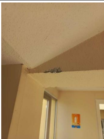
Prélèvement - P36 : CH CHOLET INTERNAT / RDC / 13.8.01.22 - Enduit- (Absence d'amiante)
