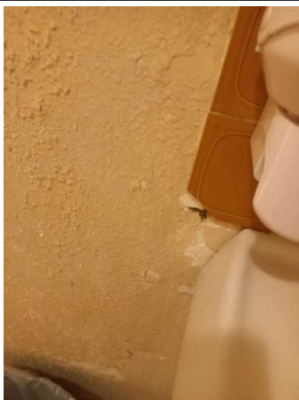
Prélèvement - P32 : CH CHOLET INTERNAT / RDC / 13.8.01.02 - Colle de faïence - BE- (Présence d'amiante)
