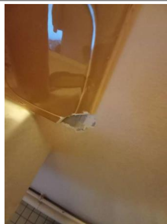
Prélèvement - P110 : CH CHOLET INTERNAT / R+3 / 13.3.01.10 - Colle de faïence- (Absence d'amiante)
