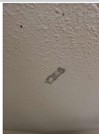
Prélèvement - P35 : CH CHOLET INTERNAT / RDC / 13.8.01.22 - Enduit - BE- (Présence d'amiante)
