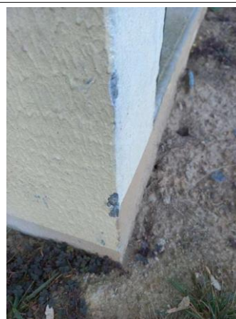
Prélèvement - P120 : CH CHOLET INTERNAT / RDC / Façade - Enduit- (Absence d'amiante)
