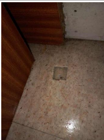
Prélèvement - P99 : CH CHOLET INTERNAT / R+3 / 13.3.01.10 - Dalle de sol- (Absence d'amiante)
