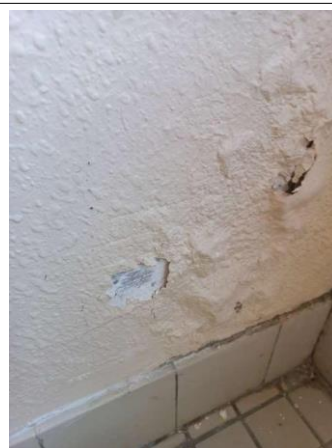
Prélèvement - P96 : CH CHOLET INTERNAT / R+3 / 13.3.01.11 - Enduit - BE- (Absence d'amiante)
