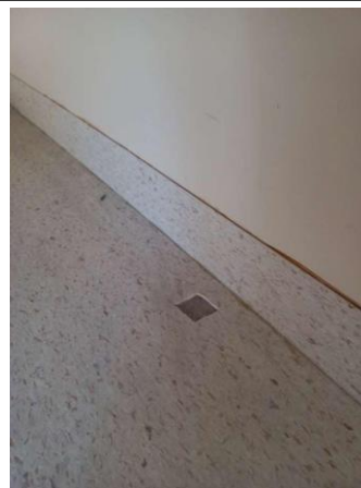
Prélèvement - P33 : CH CHOLET INTERNAT / RDC / 13.8.01.22 - Lé plastique- (Absence d'amiante)
