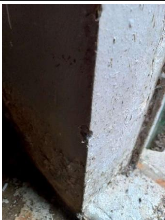
Prélèvement - P115 : CH CHOLET INTERNAT / R-1 / Station - Enduit- (Absence d'amiante)
