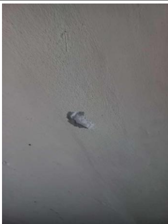
Prélèvement - P117 : CH CHOLET INTERNAT / R-1 / Station - Enduit- (Absence d'amiante)
